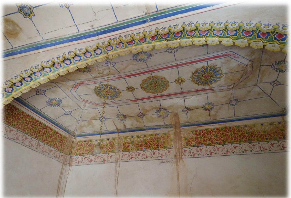
In een van de ruimtes is er nog een originele zoldering- en muurschildering. Deze kleuren werden destijds aangebracht met natuurlijke verfstoffen zoals saffraan en dergelijke.
