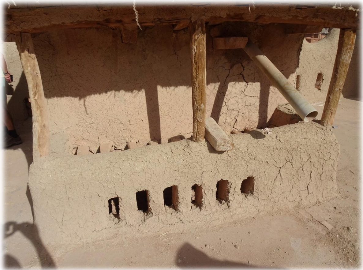
Deze kasba wordt momenteel gerenoveerd door vrijwilligers. Later zal het gebouw gebruikt worden als gîte.
